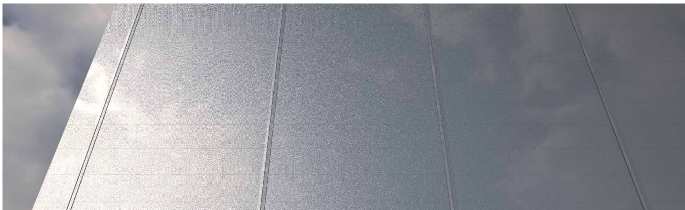
Fasad med pilaster 9
