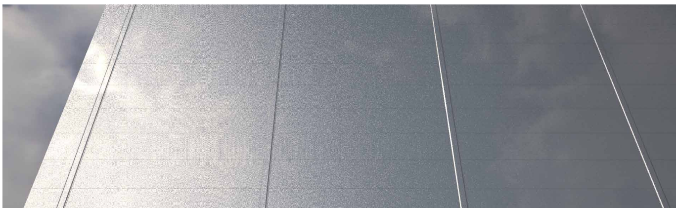
Fasad med pilaster 1
